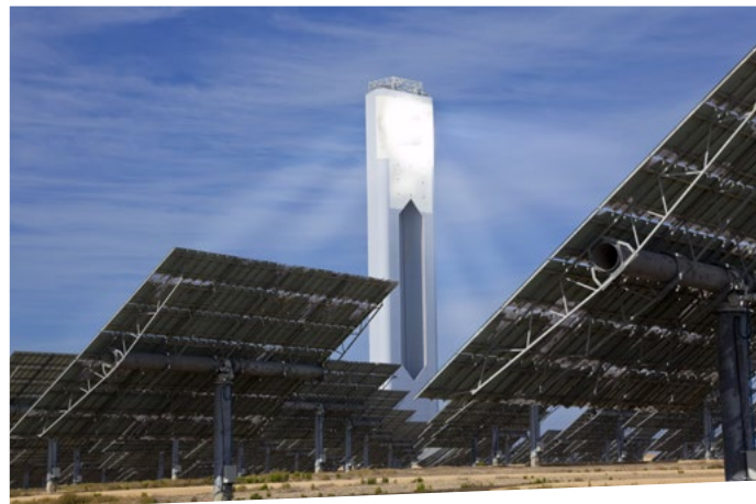
Flade spejle sender Solens stråler op imod et tårn fyldt med salt.
