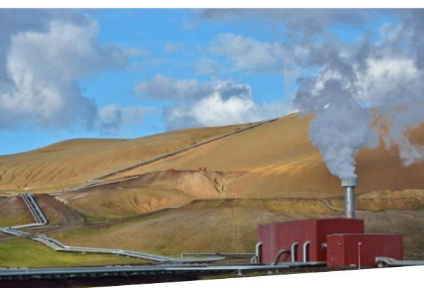
Geotermisk anlæg på Island.
