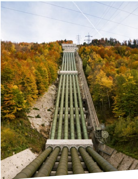
I Norges vandkraftværker benyttes dansk overskudsenergi til at skabe vandreservoirer, der fungerer som energilagere.
