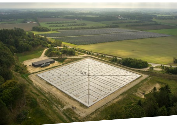
I Dronninglund i Nordjylland har man verdens største fjernvarmelager. (Foto: Arcon-Sunmark)
