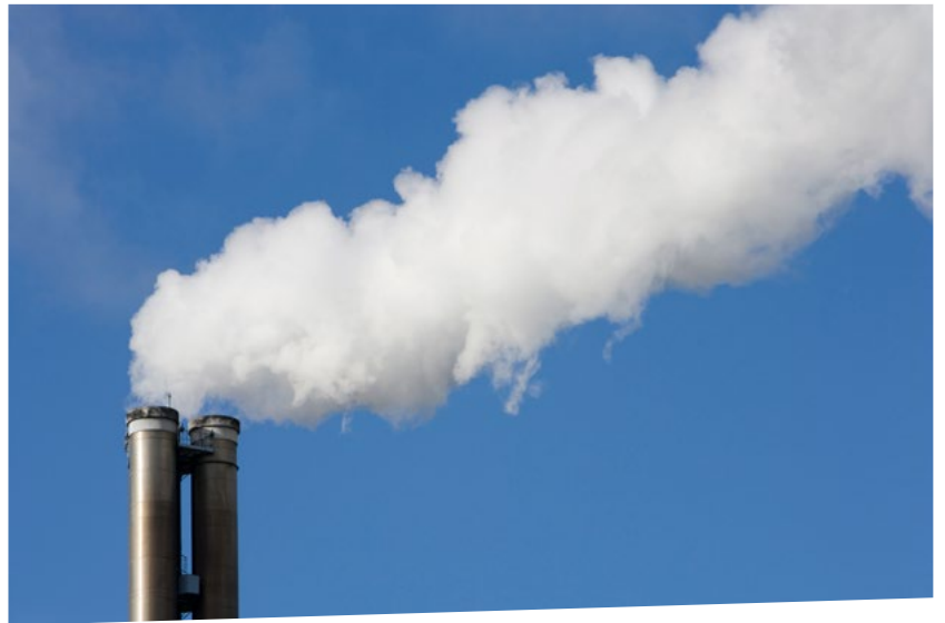
På kraftvarmeværket frigøres energi via en forbrænding.
